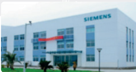
苏州西门子电器有限公司天台分公司 (制造工厂)
